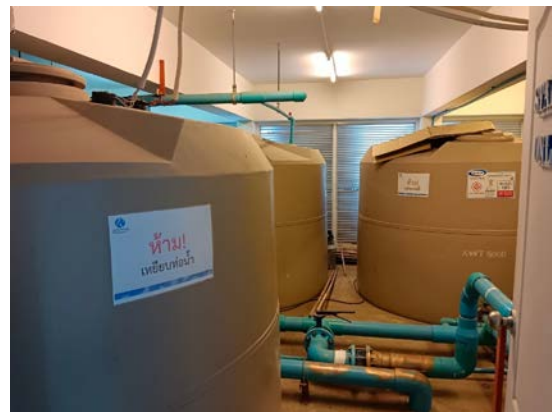
รูปที่ 2-2 ถังเก็บน้ำใช้บนชั้นหลังคา
